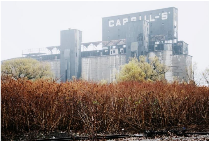
Photo 26: Silos Cargill, Buffalo, New York, États-Unis, 2012.
