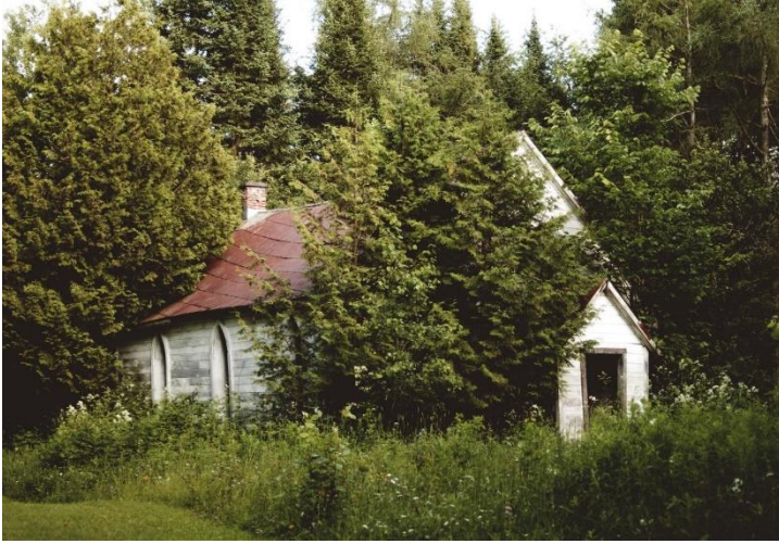
Photo 15: Église, Grenville, Québec, 2011.
